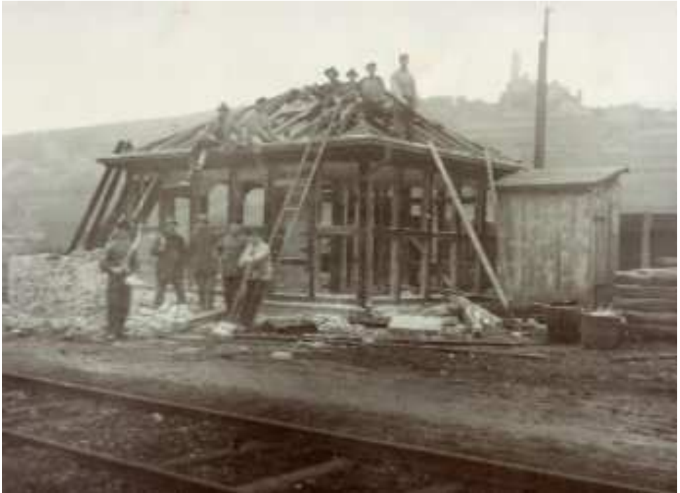
Die Schüler der Schifferschule beim Abbruch des Pfortnerhauses im Anilingelände, das später OWK - Hütte auf der Eduardshöhe wurde
